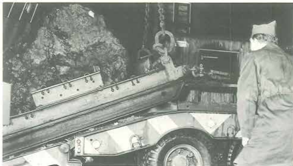
Den slæde, som blev bygget under Agpalilik i 1965, har fulgt meteoriten lige siden og i høj grad lettet håndteringen ved indskibning, flytning og savning. Her ses en situation fra Mineralogisk Museum, hvor Bjergningskompagniet er ved at indlade meteoriten på en af hærens blokvogne.
