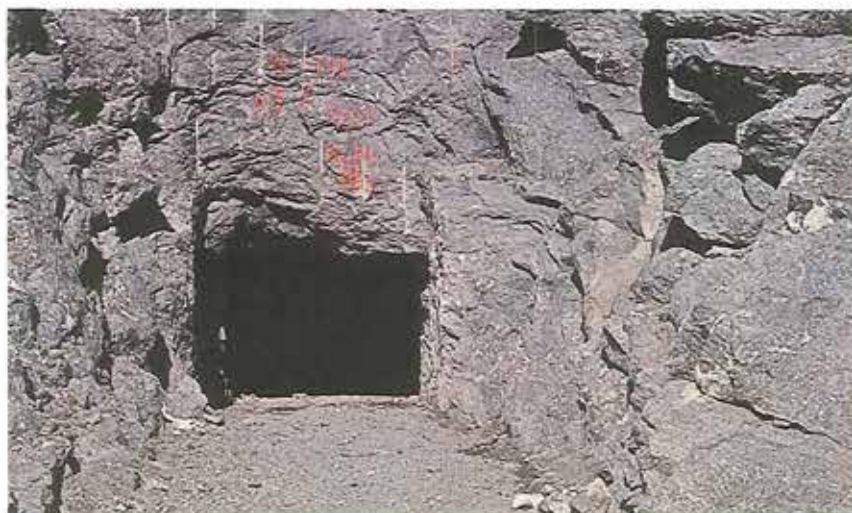
Mineskakten på Kvanefjeld, hvorfra der i 1962 blev hentet små 200 tons uranmalm til Risø. Skakten er vandret, cirka 20 m lang, og den er placeret i en uranrig bjergart rig på små lyse analcimærer (foto H.Sørensen).
