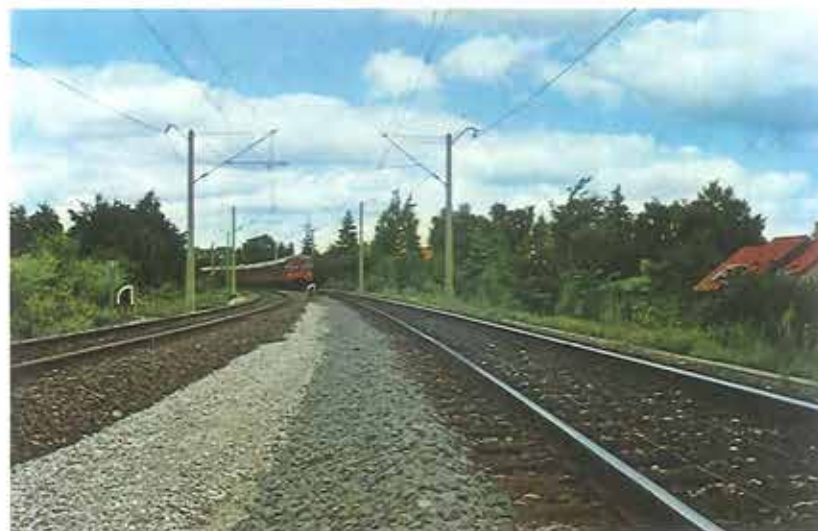
Fig. 9. Svellefundament af Rønne granit. På højre spor er netop udlagt et nyt fundament af Rønne granit. Det venstre spor er rustfarvet af slidet på spor og hjul. Imellem de to par skinner er der fyldt op med stabilgrus fra en kvartær smeltevandsaflejrning. Billedet er fra Farumbanen mellem Dyssegård og Vangede station.
