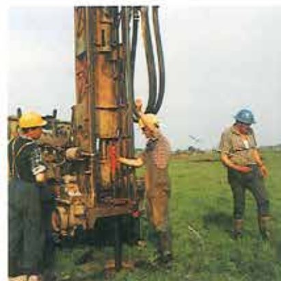
Figur 2. Efter sprænghullet er boret, sænkes ladningen ned.
