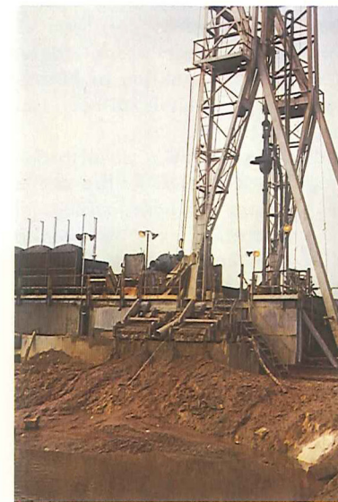
Detalje fra boreplads. Skylleprøverne udtages på sigterne i forgrunden af billedet.
