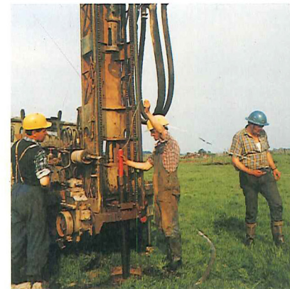
Figur 2. Efter sprænghullet er boret, sænkes ladningen ned.
