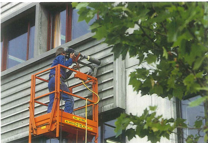
Figur 3. Udboring af betonkærne til undersøgelse af skadesramt beton.
