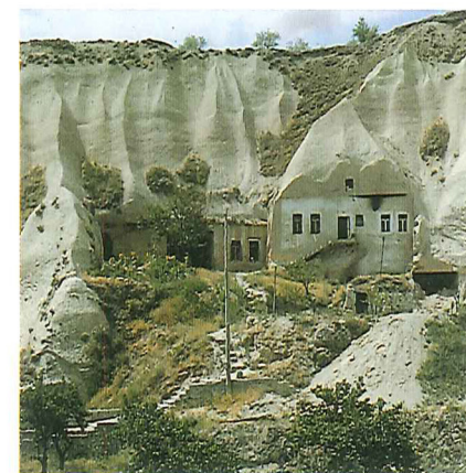
Figur 9. Beboede huler med delvis opmurede ydervægge. Bemærk, at hulerne er forsynet med elektricitet.
