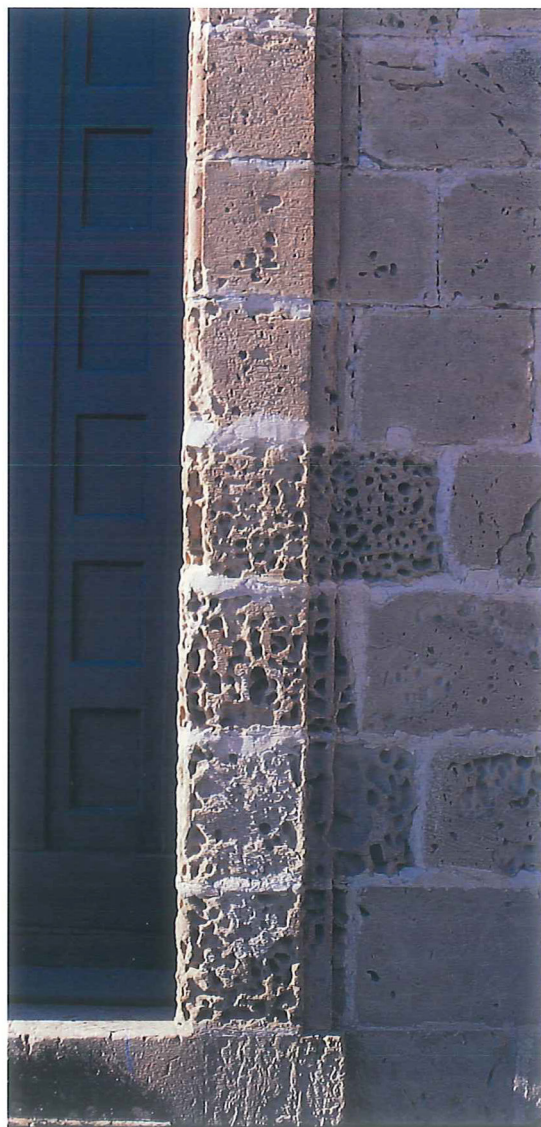
Figur 2. Dørkarm i Victoria på øen Gozo, Malta. Globigarina kalksten i forskellig forvitringsgrad.
